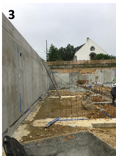
Voiles (murs béton) coté Sud du sous-sol
