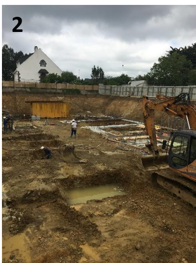
Réalisation des fondations
