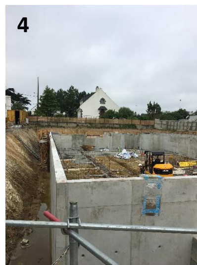
Vue générale sur les murs périphériques du sous-sol
