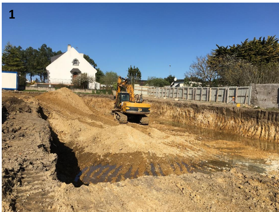
Travaux de terrassement
