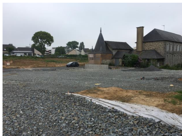
Travaux préparatoires du chantier
