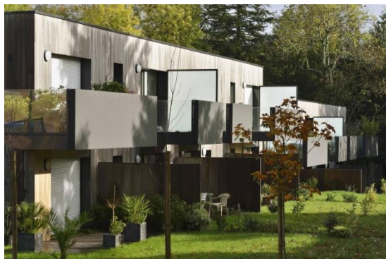
ODYSSEE Arradon (2012) 28 logements
