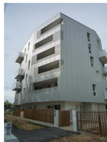
Accès au bâtiment A
