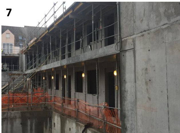
7. Façade côté cœur d'îlot
