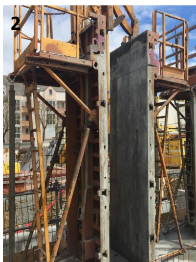
2. Zoom sur une banche : panneaux de coffrage utilisés pour réaliser les parois béton
