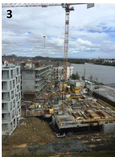
3. Vue d'ensemble du futur îlot et vue sur Loire
