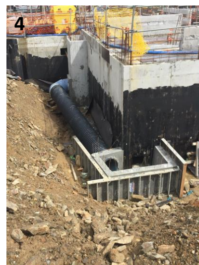
4. Gaine de ventilation et étanchéité périphérique au sous-sol
