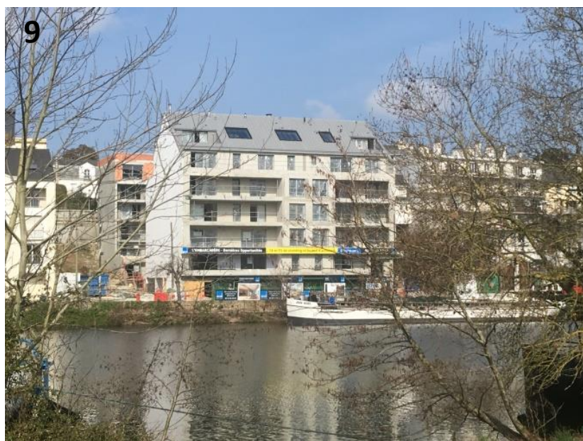
9 Façade Sud du bâtiment A vue depuis la rive opposée de l'Erdre
